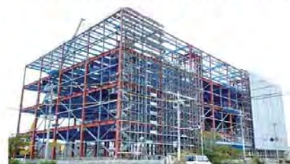
糸満西崎ロジスティクス 現場建方状況
