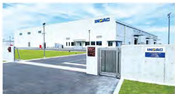
新工場(2020年6月竣工)
