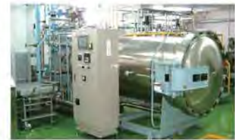
レトルト製造施設
