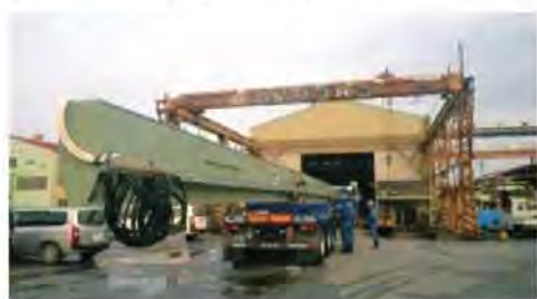
沖縄シャーリング(株)殿納めクレーンガータ搬出
