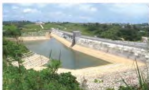
億首ダム取水放流設備製作据付工事
