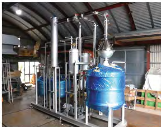
300L泡盛製造蒸留機
