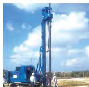
鋼管杭 杭打ち状況 (DHJ-15型)
