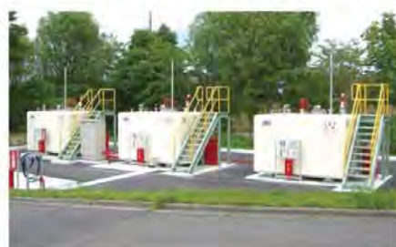
コンボルト型タンクの外観
