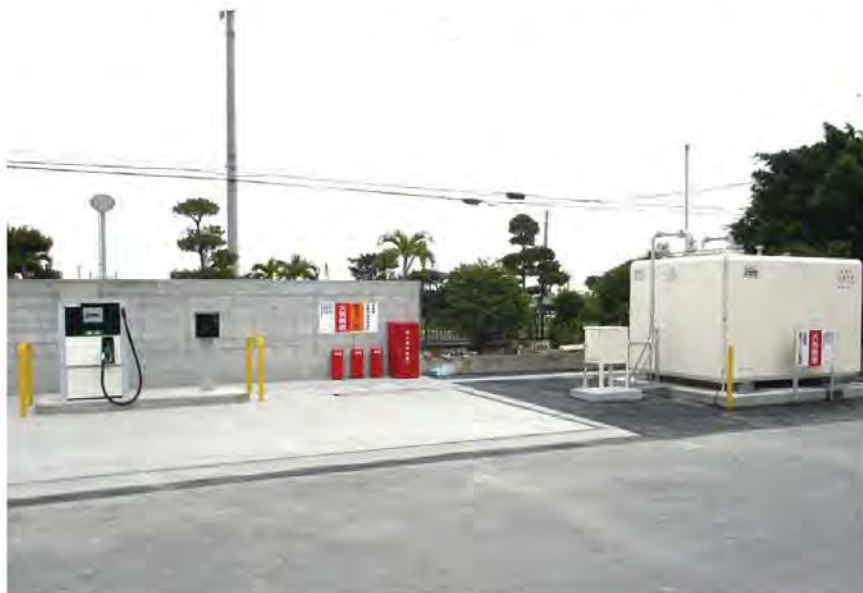
国内初の屋外燃料貯蔵タンクを使用した自家用給油取扱所
