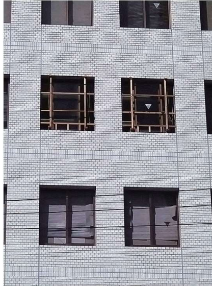
治具の設置状況 (外から撮影)
