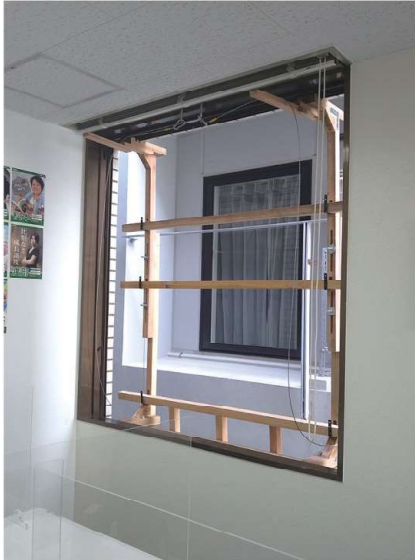
治具の設置状況 (部屋内から撮影)
