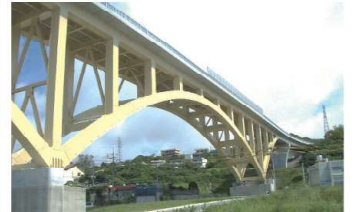
県道36号線橋梁整備工事
