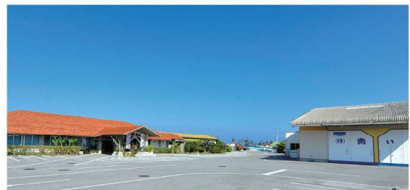
シママース本舗青い海本社工場
