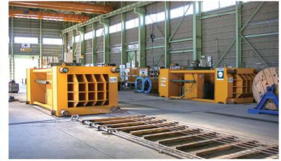
第一工場_緊張設備
