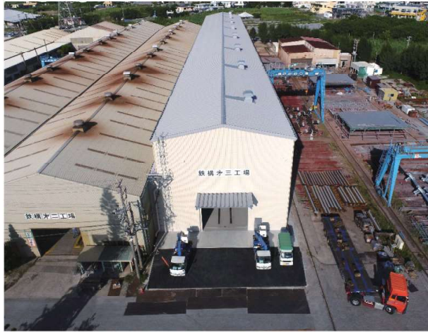
第三工場全景
