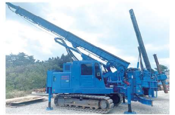
鋼管杭 施工機械 (DHJ-25型)
