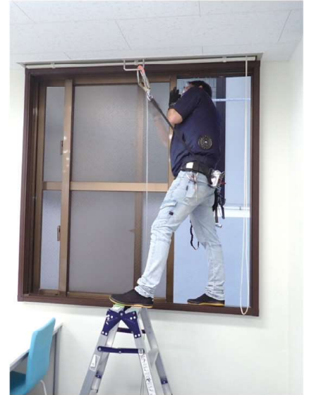
安全対策の様子 (滑落防止器具を着用し作業)
