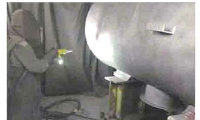
大きなオイルタンク側面へのプラスト施工状況
