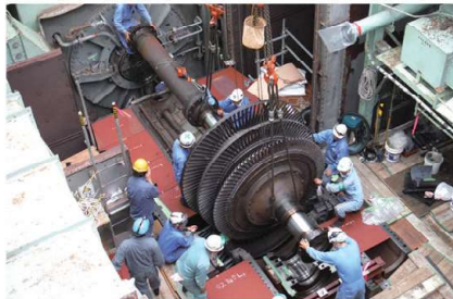
発電プラント工事
