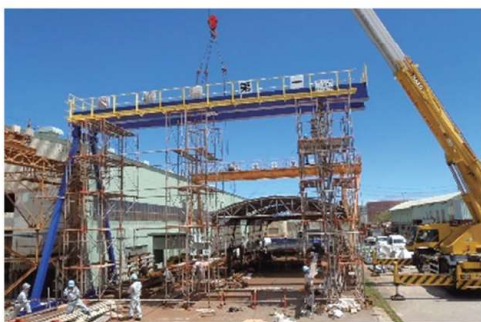
自社工場・自社製橋形クレーン7.5t製作据付
