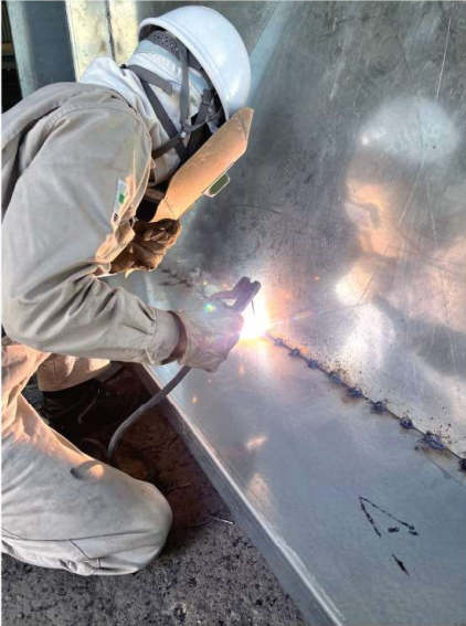
工場内作業 アーク溶接
