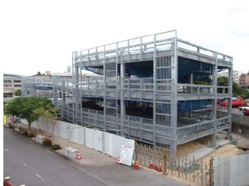
納入実績：那覇市内立体駐車場
