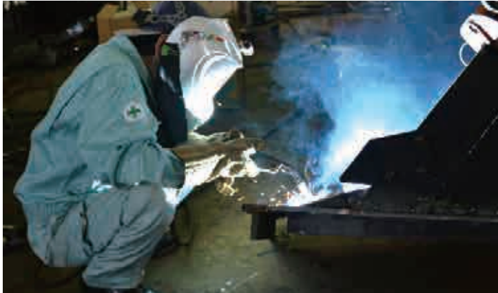
建設機械アタッチメントの溶接をしている様子
