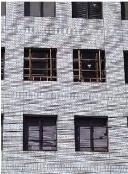
治具の設置状況 (外から撮影)
