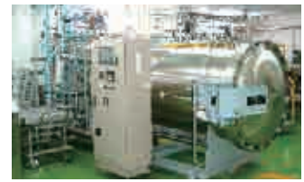
レトルト製造施設
