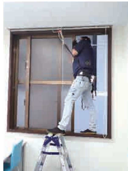
安全対策の様子 (滑落防止器具を着用し作業)
