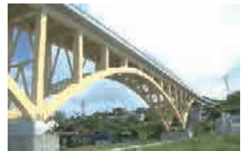
県道36号線橋梁整備工事
