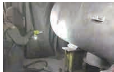
大きなオイルタンク側面へのブラスト施工状況
