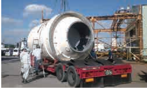
沖縄電力(株)金武火力殿納めサイロ搬出
