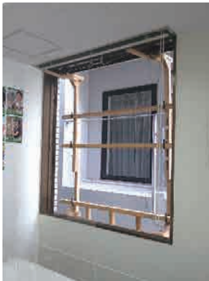
治具の設置状況 (部屋内から撮影)
