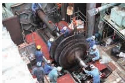
発電プラント工事
