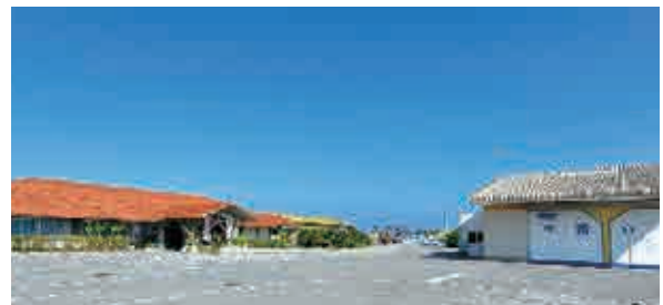
シママース本舗青い海本社工場
