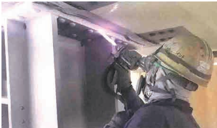
落橋防止装置への金属溶射（アルミ・マグネシウム合金）
