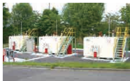
コンボルト型タンクの外観
