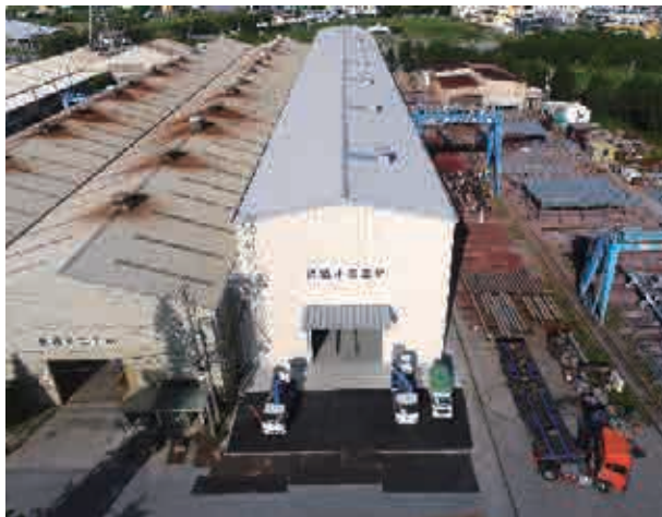
第三工場全景
