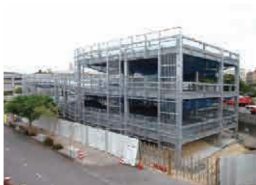
納入実績：那覇市内立体駐車場
