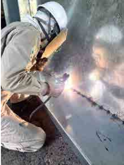
工場内作業 アーク溶接
