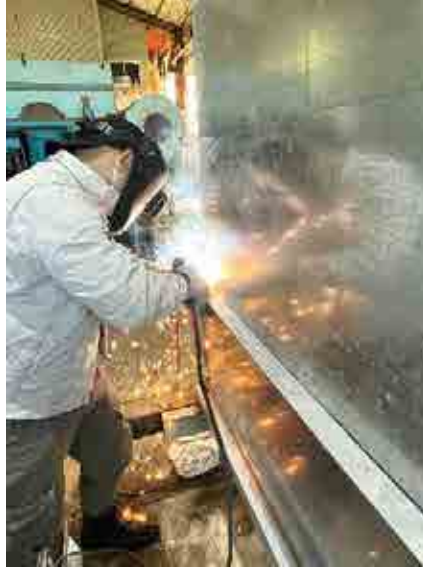
工場内作業 アーク溶接
