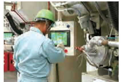
火葬炉 作業風景
