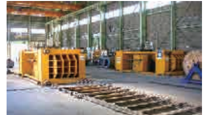
第一工場_緊張設備
