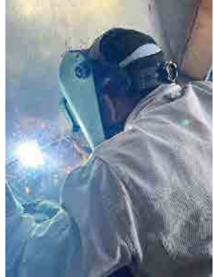
工場内作業 アーク溶接
