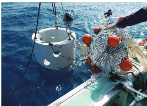
国頭漁協関係者らによる試験魚礁（円筒型魚礁）設置の様子
