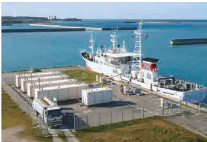
コンボルト型タンクを使用した船舶給油取扱所
