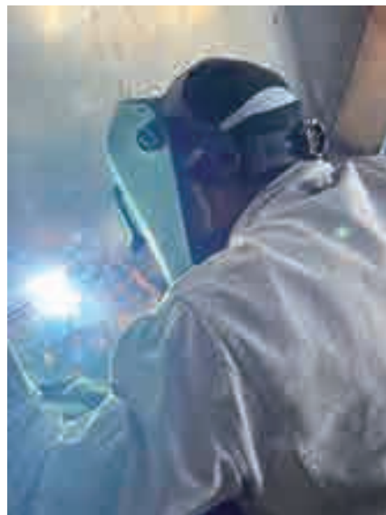
工場内作業 アーク溶接
