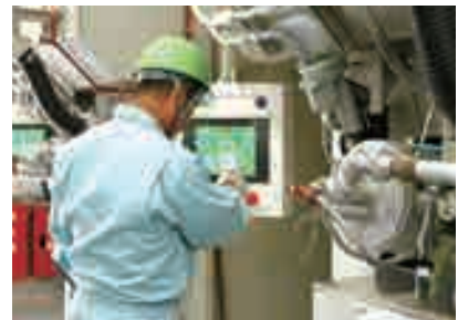
火葬炉 作業風景
