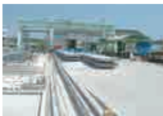
工場製造作業所
