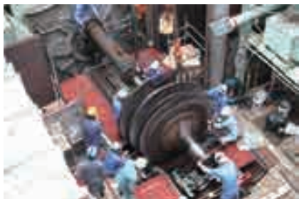
発電プラント工事
