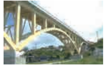
県道36号線橋梁整備工事
