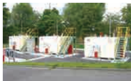
コンボルト型タンクの外観
