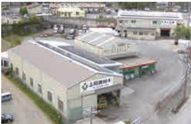
上間鋼材株式会社 構内
