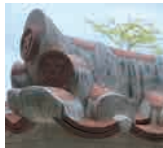
瓦・漆喰（施工前）
