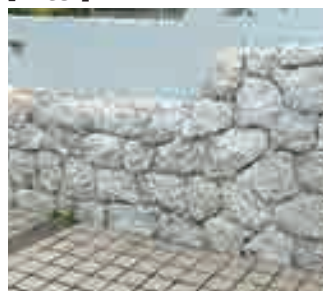
琉球石灰岩（施工後1年経過）
