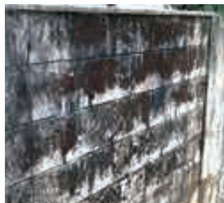
ブロック塀（施工前）
