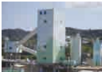
バッチャープラント
