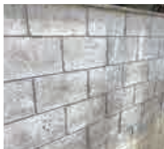
ブロック塀（施工後1年経過）
