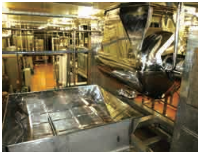
原料抽出工程
