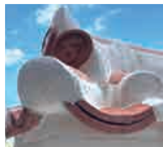
瓦・漆喰（施工後9ヶ月経過）
