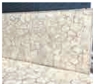
琉球石灰岩（施工後1年経過）
