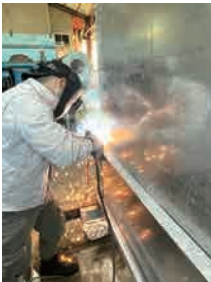
工場内作業 アーク溶接
