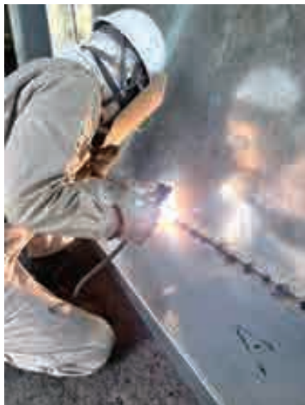
工場内作業 アーク溶接
