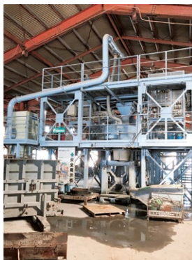
県外から技術者を招いて開発・設置したレジンコンクリート製造装置
