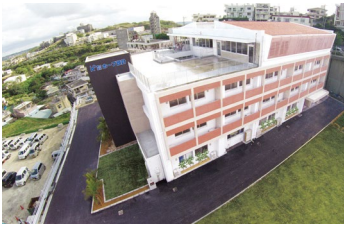
2015年4月新築の自社ビル。1階には従業員のためのトレーニングルームも完備
