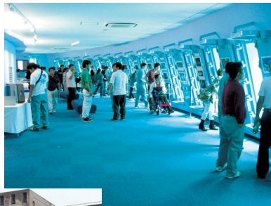
宮古島海中公園の海中観察施設。アクリル観察窓を組み込んだプレキャスト（コンクリート流し込み）の枠を海中に沈めてつなげ、鋼線で締め付けてから内部の海水を抜く国内初の工法を試みた
