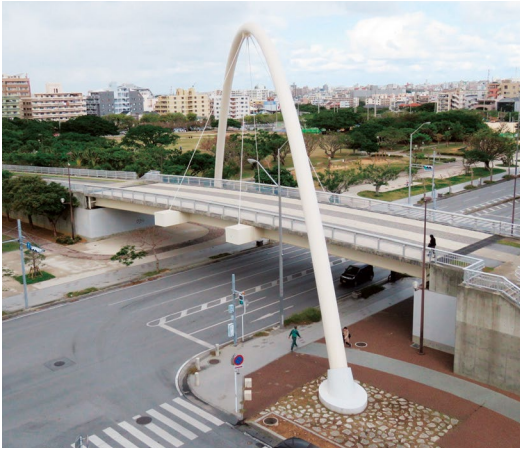
那覇新都心公園「おもしろ天空橋」。非常時には車輪通行も可能
