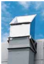
写真左) 煙突のような形で、太陽光を室内に取り入れる光ダクト(下) 遮光された室内には光ダクトから太陽光が入り、植物の成長に必要な光のみが届くようになっている。24時間の監視体制で植物の成長具合をチェック
