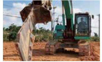
離島での試験圃場施工の様子
