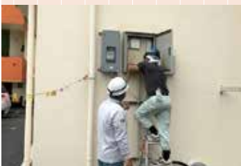
現場作業風景 (にへでホーム)
